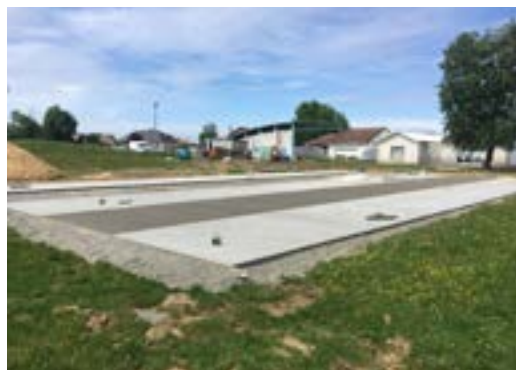
Dallage béton poreux
