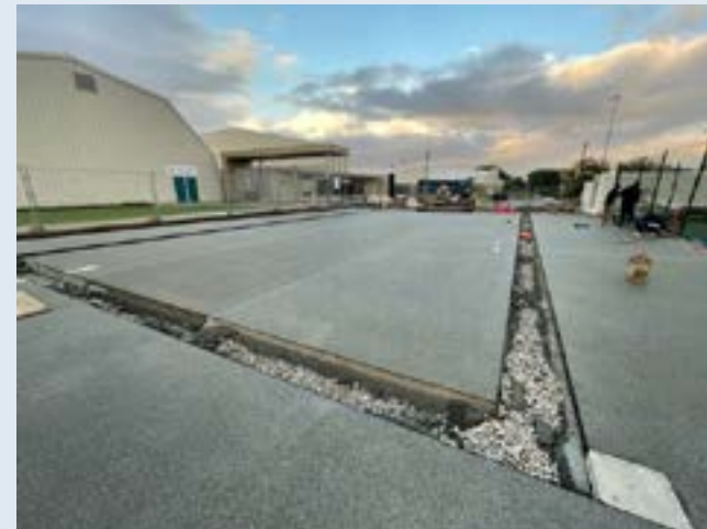
Dallage béton poreux
